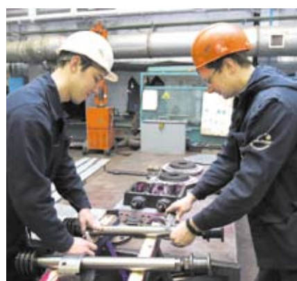
Слесари по ремонту технологических установок Денис Игнатович и Сергей Кириллов выполняют капитальный ремонт парового насоса с установки «Деасфальтизация»
