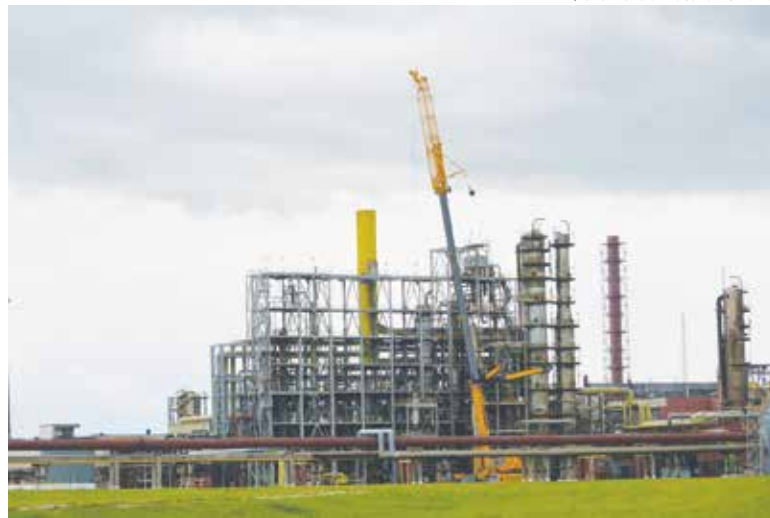
750-тонный кран был задействован на ремонте на этажерке блока очистки акрилонитрила
