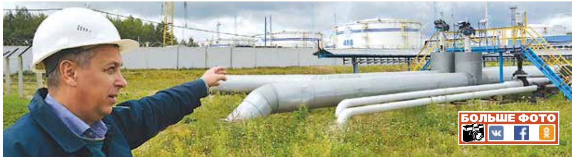
Заместитель начальника цеха № 8 Сергей Шарков показывает место, где трубопроводы выходят из-под земли
